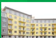
PODĚBRADY /bytový dům/ zateplení fasády
