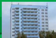
OSTRAVA-Hrabůvka / bytové domy / zateplení fasády a střechy, výměna oken
