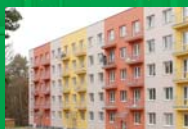
MILOVICE / bytový dům / zateplení fasády, sanace balkonů
