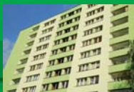
OSTRAVA - Poruba / bytový dům / zateplení fasády, sanace balkonů, výměna oken
