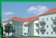
ČASLAV / bytové domy / zateplení fasády, vnitřní omítky
