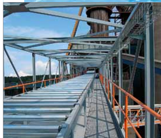
Montáž dopravníkového mostu v cementárně. ▶
