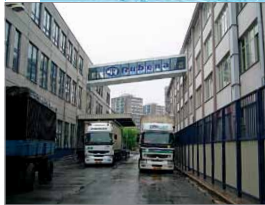
Ocelový opláštěný most pro dopravníkový systém. ▶
